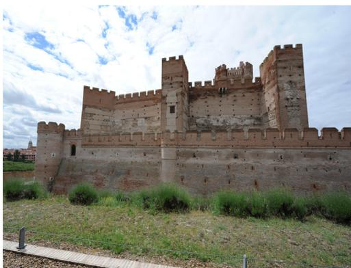
Figura 4. Lienzo sur, se aprecian los restos originario de muralla de la repoblación (S. XII) en tapia unitaria a la que se unieron posteriormente las torres de planta rectangular levantadas en muro mixto.
