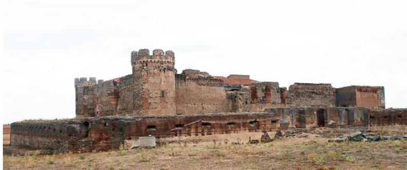
Figura 11. Imagen exterior del castillo de Castronuevo en Rivilla de Barajas. AV. Se aprecian dos de las torres semicirculares del recinto exterior levantadas con tapia mixta reforzada con machones de ladrillo.
