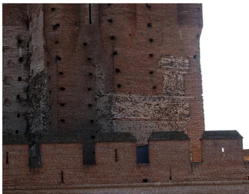
Figura 5. Detalle de la primera torre. Frentado con verdugada de dos hiladas de ladrillo. Castillo de la Mota. Medina del Campos. VA.
