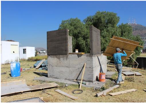
Figura 2. Módulo experimental realizado en 2014 con TVC. Mide 2.4m de lado y los muros poseen 14cm de espesor. Zacatenco, México D.F. Foto: Luis Guerrero.
