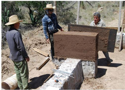
Figura 5. La dimensión de los encofrados facilita su transportación y colocación, además de propiciar una rápida compactación. Tlaxco, Tlaxcala, Foto: Blas Antonio Tepale.
