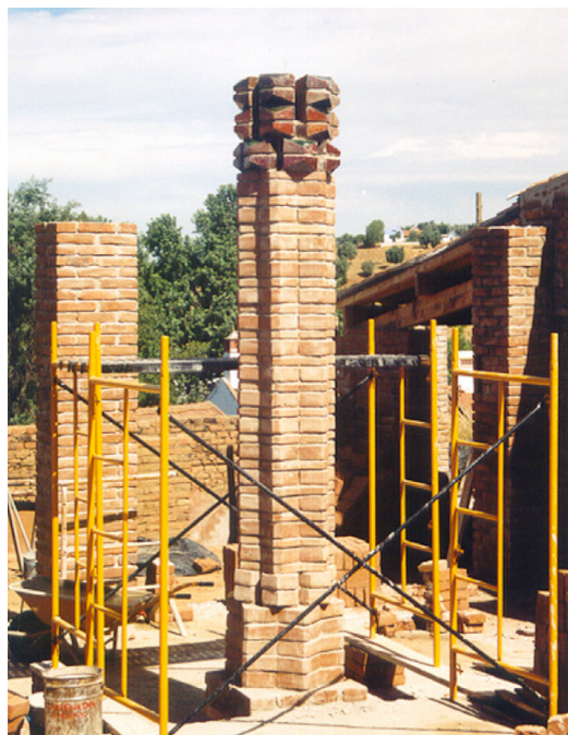
Figura 1. Coluna de Sandra Casaca durante a construção e ampliação da estrutura do telheiro em 2000/20001. Fonte: Tiago Fróis.
