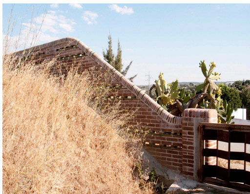
Figura 7. Vista de O Muro do lado do Telheiro. Fonte: Marta Castelo.
