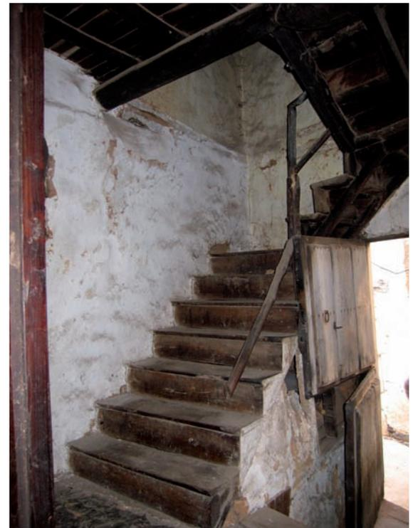
dra que hace las veces de basamento. De manera que la estructura vertical del edificio combina los muros de mampuestos de piedra, en planta baja (que se corresponde con la bodega y la cuadra), con muros de entramado de madera cuajados de ladrillo, en las dos plantas de la vivienda, para solucionar tanto los muros de las fachadas como la tabiquería interior. En la bodega se disponen dos pies derechos de madera que descargan la viga sobre la que apoyan los tabiques de las plantas superiores.
